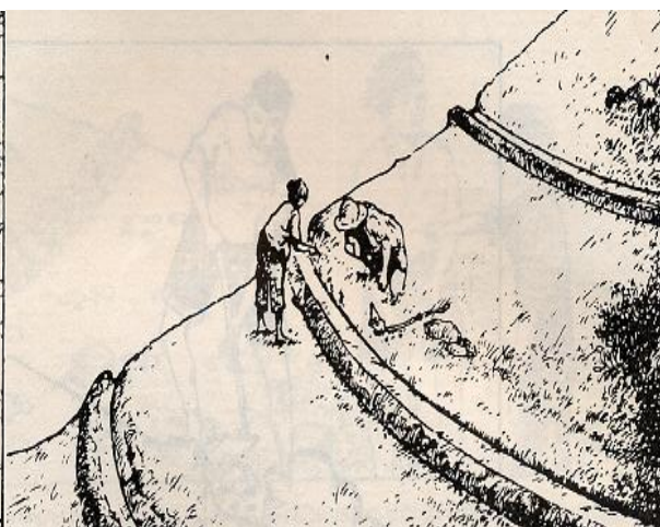
Đắp bờ, xẻ rãnh chống rửa trôi xói mòn
