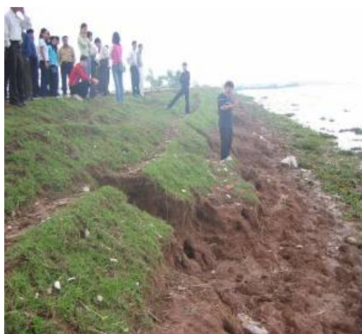
Hình 6. 0,65km đê quốc gia ở xóm Tân Bồi, xã Thái Đô bị xói lở sau cơn bão số 7 vì không có RNM bảo vệ (A); 5km đê ở xã Thái Đô được bảo vệ hoàn toàn không bị sóng do bão số 7 làm xói lở (B)
